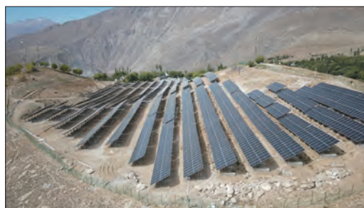
한수원이 공적개발원조(ODA) 사업으로 타지키스탄 최초 메가와트급 태양광 발전소를 준공했다. 사진=한국수력원자력
